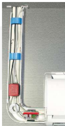
Posa tubazioni E pompetta
