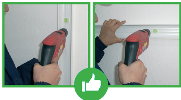
Installazione canalina con bolla incorporata
