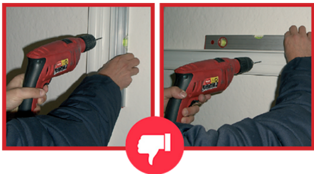
Installazione canalina senza bolla incorporata
