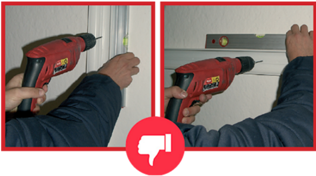
Installation goulotte sans bulle intégrée
