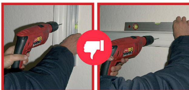
Kabelkanalinstallation ohne eingebaute Wasserwaage
