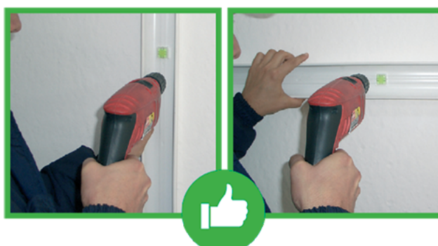
Kabelkanalinstallation mit eingebauter Wasserwaage
