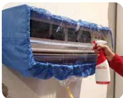
Pulizia batteria con telo di protezione applicato
