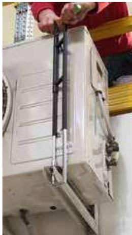
La chiave permette un rapido serraggio dei bulloni tra unità esterna e staffa a parete. Ideale per fissare l'unità esterna in condomini, terrazzi, davanzali, finestre. **Senza l'installazione di ponteggi.**
