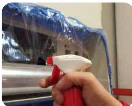
Pulizia batteria tramite foro inserimento spruzzino
