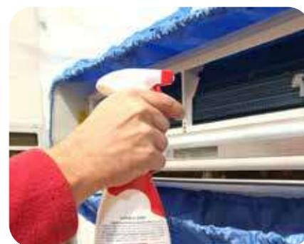
Pulizia batteria senza telo di protezione
