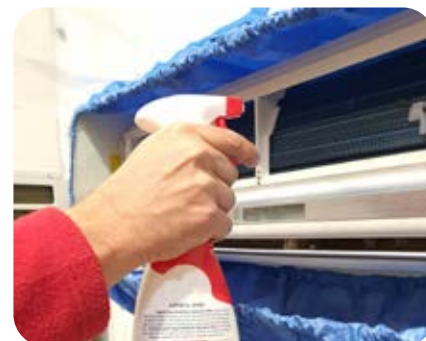
Pulizia batteria senza telo di protezione
