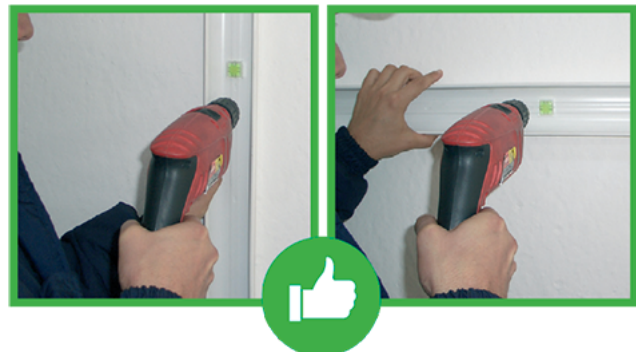
Installation goulotte avec bulle intégrée
