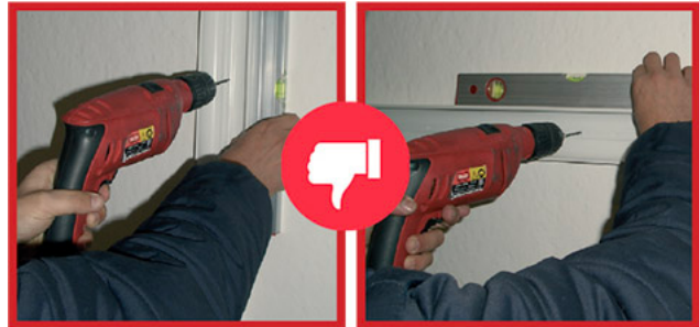
Kabelkanalinstallation ohne eingebaute Libelle
