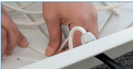
STENDERE ED INCASTRARE IL CAVO SCALDANTE IN TUTTE LE SEDI FINO AL COMPLETAMENTO. / ROUTE THE HEATING CABLE AND PUSH IT ALONG THE FLOWER-SHAPED HOUSING.
