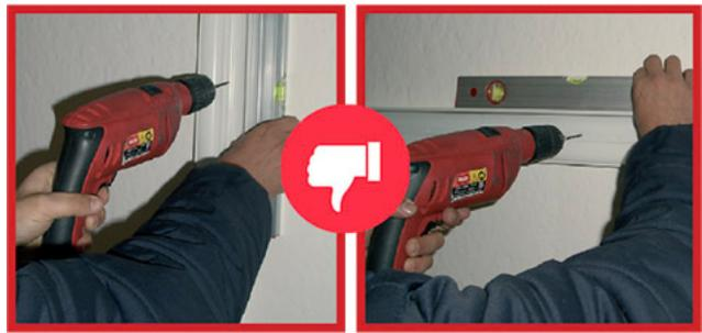
Installazione canalina senza bolla incorporata
