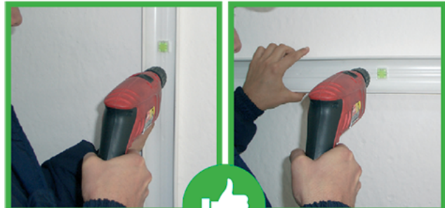
Installazione canalina con bolla incorporata
