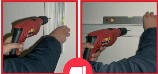
Installazione canalina senza bolla incorporata
